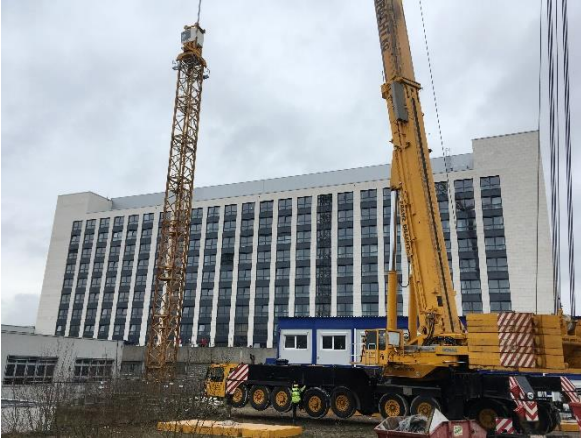
Feierabend nach sechs Jahren: Der Liebherr Kran auf dem Klinikum-Gelände wird abgebaut.
